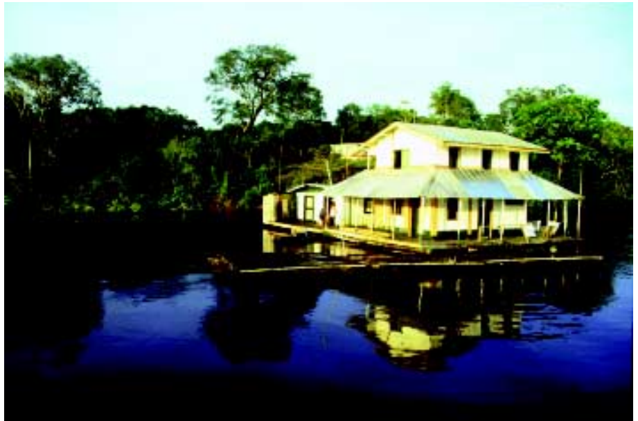
CASA FLUTUANTE DO IBAMA, PARQUE NACIONAL DO JAÚ, AM
